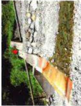
ずれる構造とすることで、左右岸からの土圧を逃がす仕組みのダム (Dürnbach)
