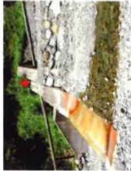
ずれる構造とすることで、左右からの土圧を逃がす仕組みのダム (Dürnbach)
