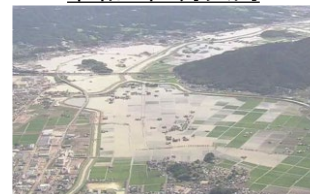
⑬六角川周辺における浸水被害状況 (佐賀県武雄市)
