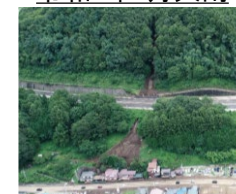
⑭土砂災害の状況 (長野県岡谷市)
