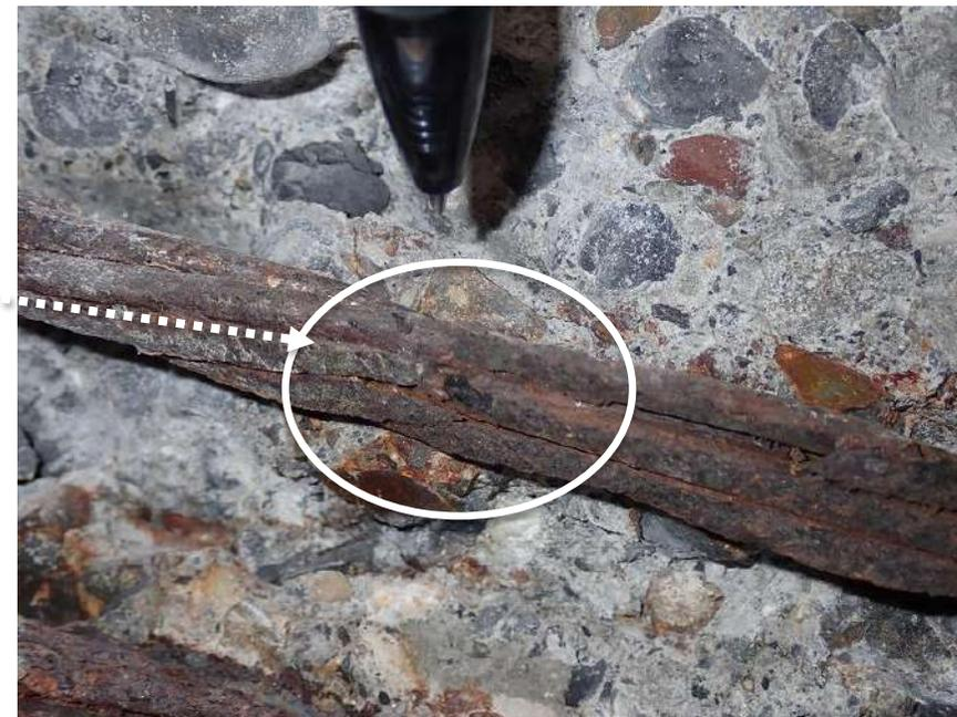
電柱や投光器の支柱内部には、支える為の内部鋼材が橋梁と同じように入っており、それが腐食、破断をすると非常に危険な状態になります。
